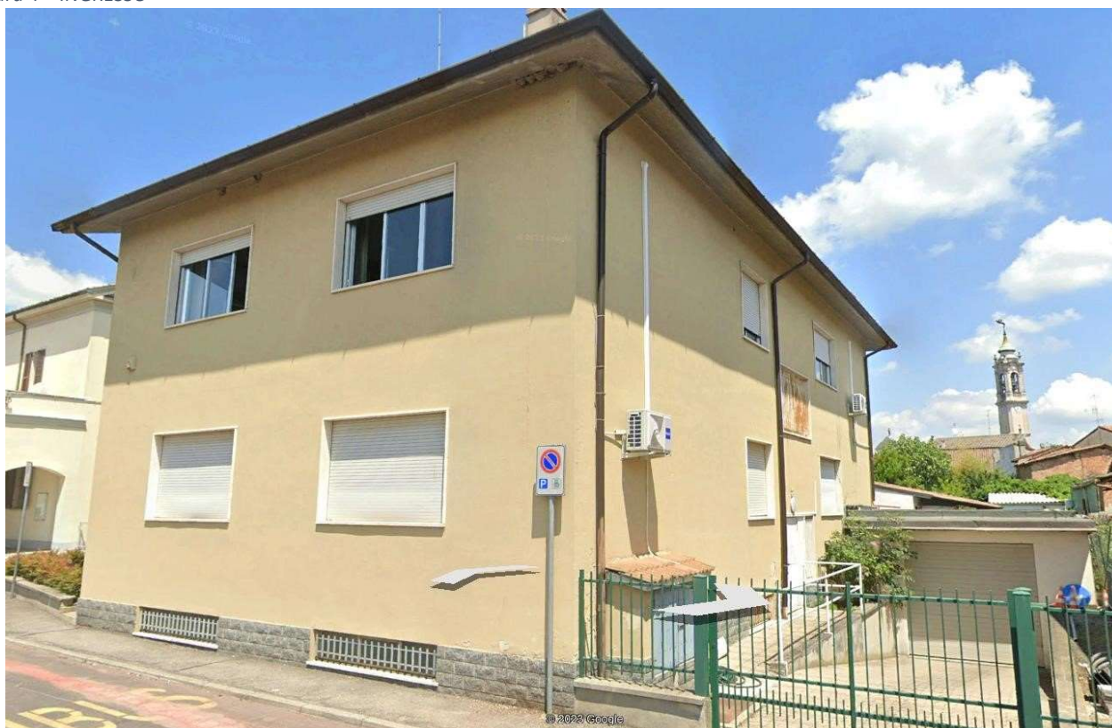
Figura 5 - FACCIATA E ACCESO GARAGE
