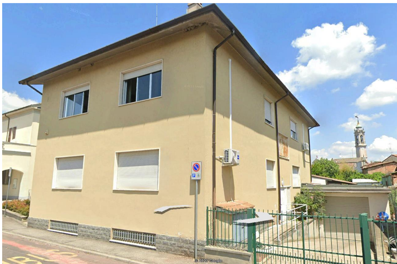
Figura 5 - FACCIATA E ACCESO GARAGE
